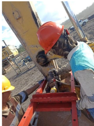
Gambar 4. Pemasangan Pin Menggunakan Special Tool
