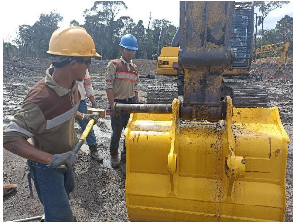
Gambar 1. Pemasangan Pin Menggunakan Palu
