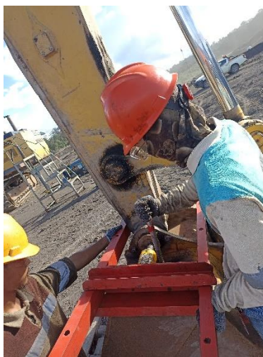
Gambar 4. Pemasangan Pin Menggunakan Special Tool
