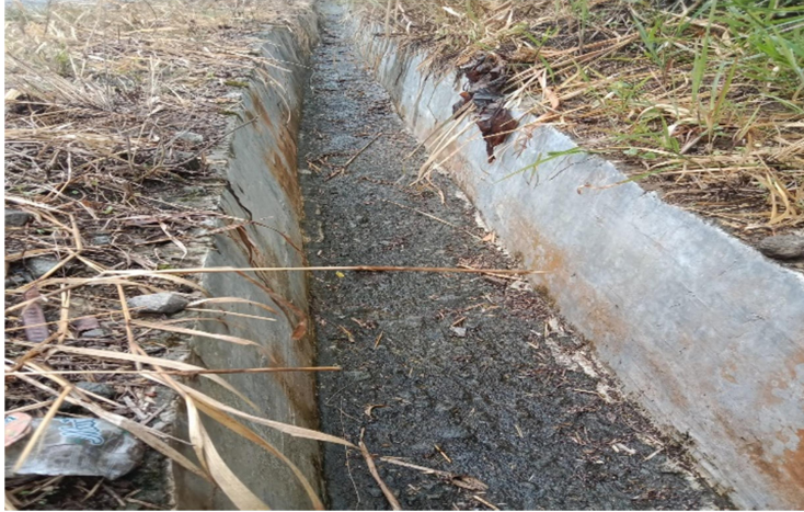
Gambar 3. Drainase Setelah Dibersihkan
