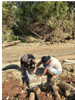
Gambar 2. Persiapan pondasi tiang PJU.
