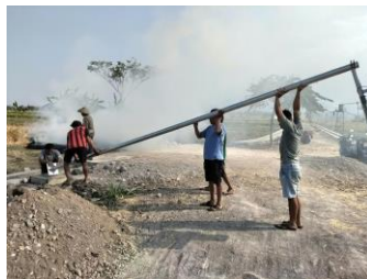
Gambar 3. Pemasangan tiang secara gotong royong.
